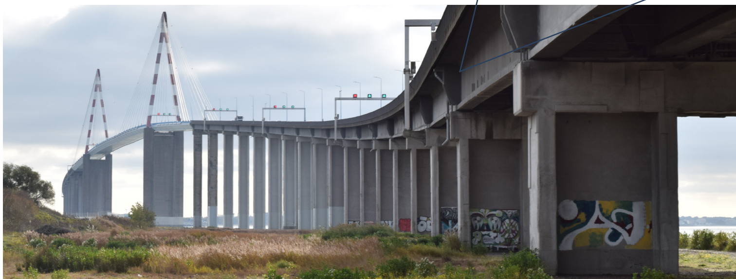
Saint-Nazaire-bron byggdes på 1970-talet och är fortfarande den längsta bron i Frankrike. Mervärdet av armeringen var inte skyddad mot korrosion, och detta har lett till att ett omfattande program för underhåll och reparationer har behövt utarbetas. Bron innehåller dock ca 63 ton varmförzinkad armering, placerad inom vissa specifika områden. Dessa områden utgörs av flänsarna på T-balkarnas ändrar samt de på platsen gjutna anslutningsplattorna i höjd med flänsarna (bilden ovan). Inom dessa områden har inga reparationer behövt utföras.
