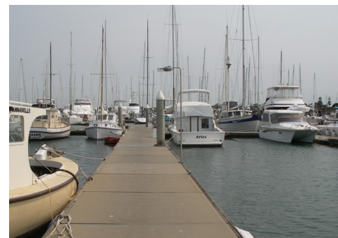
De flytande pontonerna vid marinan i Sandringham, Victoria (Australien) använder varmförzinkad armering
