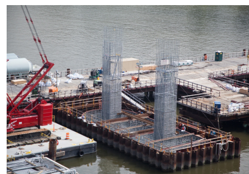
Över 27 000 ton varmförzinkad armering säkerställer långvarig hållbarhet hos pyloner, påfartsramper och farbanesegment på Mario M. Cuomo-bron.
