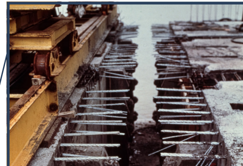
Brodäcket på Mario M. Cuomo-bron består av nästan 6000 prefabricerade segment, var och en 3,66 m långt och 6,7-13,7 m brett, för påfarten. Där utöver ingår 963 däckspaneler. Segmenten sammanfogas genom att betong gjuts runt den utstickande varmförzinkade armeringen. (Bild med tillstånd från New Yorks Genomfartsmyndighet)
