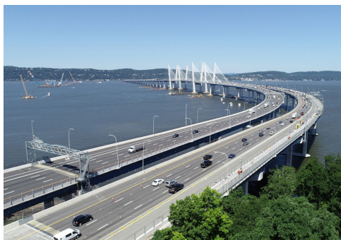
Mario M. Cuomo-bron är en 5 km lång, 8-filig dubbelspans kabelstagsbro, designad för en livslängd på minst 100 år med hjälp av varmförzinkad armering.
