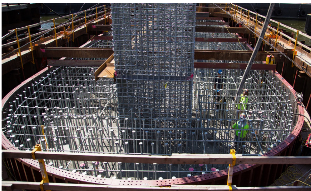
Mario M. Cuomo-brons 43 par betongpiper är förstärkta av varmförzinkat armeringsstål.
