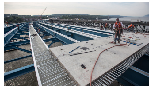
Brodäcket på Mario M. Cuomo-bron består av nästan 6000 prefabricerade segment, var och en 3,66 m långt och 6,7-13,7 m brett, för påfarten. Där utöver ingår 963 däckspaneler. Segmenten sammanfogas genom att betong gjuts runt den utstickande varmförzinkade armeringen. (Bild med tillstånd från New Yorks Genomfartsmyndighet)
