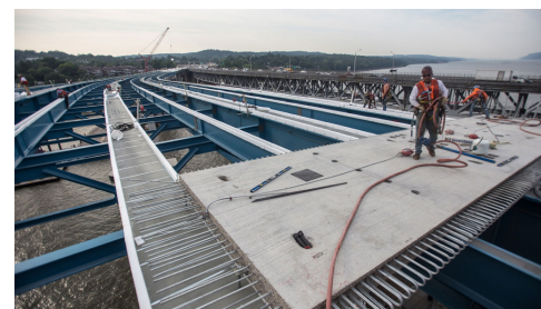
La cubierta del Puente Mario M. Cuomo está formada por cerca de 6.000 paneles de hormigón prefabricado de 3,66m de largo por 6,7-13,7m de ancho, para los vanos de acceso y los 963 tableros de cubierta del vano principal. Los tableros están unidos mediante hormigón vertido alrededor de la armadura galvanizada (Imagen cortesía de Autoridad de Autopistas del Estado de Nueva York).
