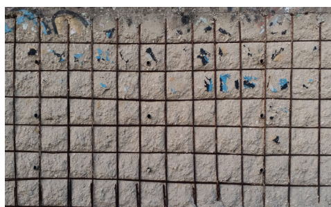
Agrietamiento y desconchado del hormigón debido a la corrosión de la armadura
