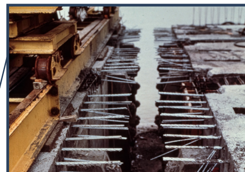
La cubierta del Puente Mario M. Cuomo está formada por cerca de 6.000 paneles de hormigón prefabricado de 3,66m de largo por 6,7-13,7m de ancho, para los vanos de acceso y los 963 tableros de cubierta del vano principal. Los tableros están unidos mediante hormigón vertido alrededor de la armadura galvanizada (Imagen cortesía de Autoridad de Autopistas del Estado de Nueva York).
