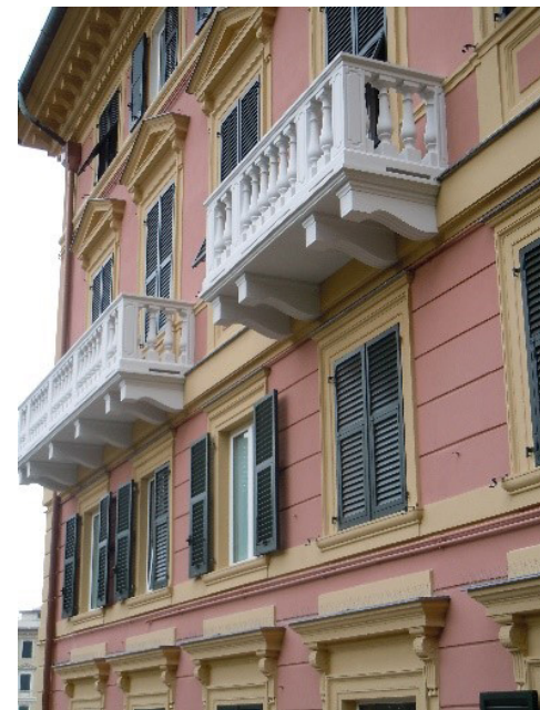
Vigas de soporte de hormigón armado con acero galvanizado en caliente para los balcones de un elegante apartamento en Génova. Se eligieron armaduras de acero galvanizado para preservar mejor en el tiempo las vigas de soporte de los balcones y protegerlas del smog, la lluvia, las heladas y la humedad. (Imágenes cortesía de Prefabbricati Torti di Pietro e Lino Torti snc)
