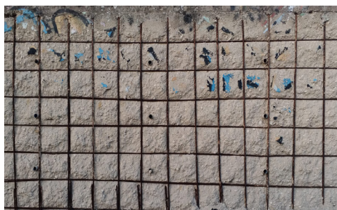
Agrietamiento y desconchado del hormigón debido a la corrosión de la armadura
