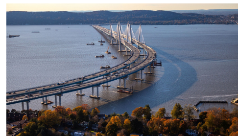
El recientemente inaugurado Puente Mario M. Cuomo es el puente más largo construido en la ciudad de Nueva York. Este nuevo puente reemplaza al anterior Tappan Zee Bridge sobre el Río Hudson al norte de la ciudad.
