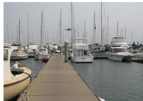
Los pontones flotantes del puerto deportivo de Sandringham, Victoria (Australia) con armadura galvanizada
