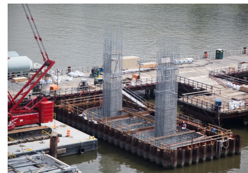
Más de 27.000 toneladas de armadura galvanizada garantizan la máxima durabilidad de las torres del vano principal, los pilares del tramo de acceso, los estribos y los tableros de la plataforma del puente Mario M. Cuomo.
