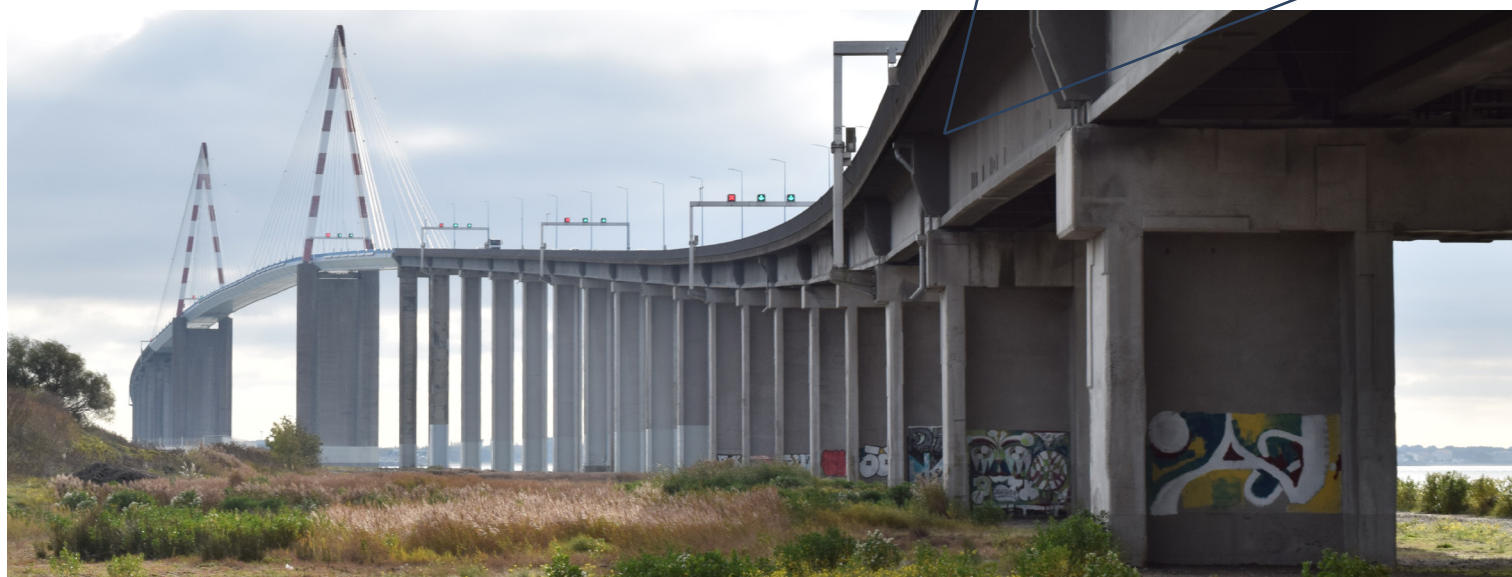
El puente de Saint-Nazaire fue construido en la década de 1970 y sigue siendo el puente más largo de Francia. La mayor parte de su armadura de hormigón no estaba protegida contra la corrosión, lo que provocó un extenso programa de mantenimiento y reparaciones. Se utilizaron alrededor de 63 toneladas de armadura galvanizada en lugares muy específicos: los refuerzos en los apoyos de las vigas en T y las losas de conexión vertidas in situ a la altura de los refuerzos (en la imagen de arriba). No han sido necesarias reparaciones en los lugares específicos donde se utilizó la armadura galvanizada.
