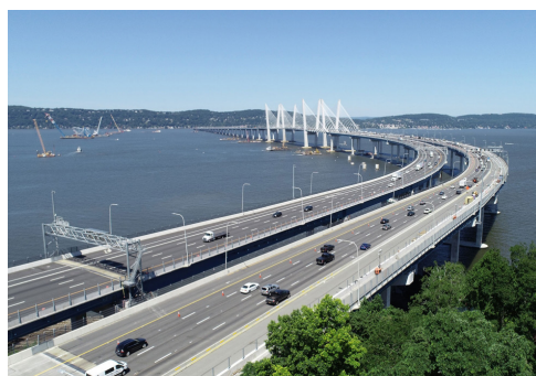
El puente Mario M. Cuomo es un puente atirantado de dos tramos de 5 km de largo y 8 carriles diseñado con armaduras galvanizadas para alcanzar una vida útil mínima de 100 años.
