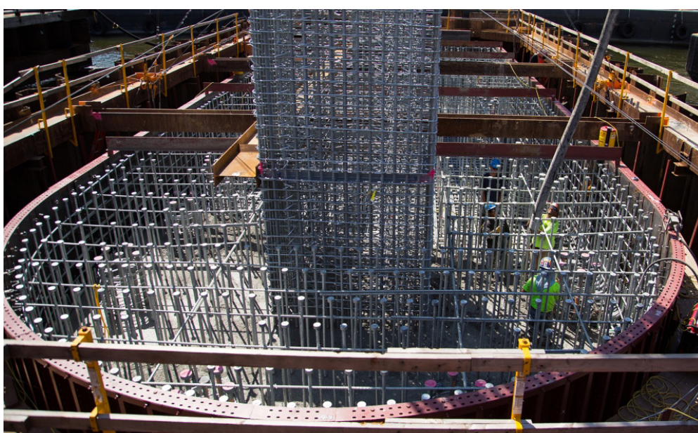
Los 43 pares de pilares de hormigón del Puente Mario M. Cuomo están reforzados con jaulas de armadura galvanizada.
